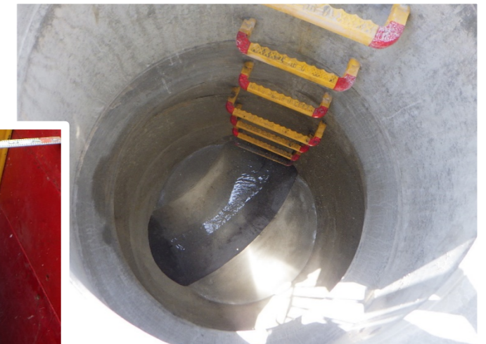
マンホール内部
