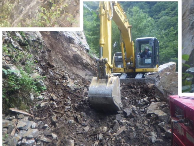
落石の撤去状況
