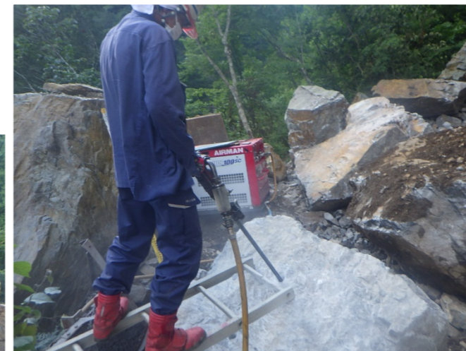
落石割り状況
