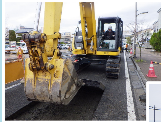
重機での掘削
