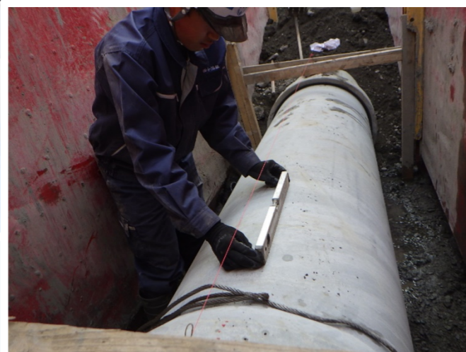
下水道管設置状況
